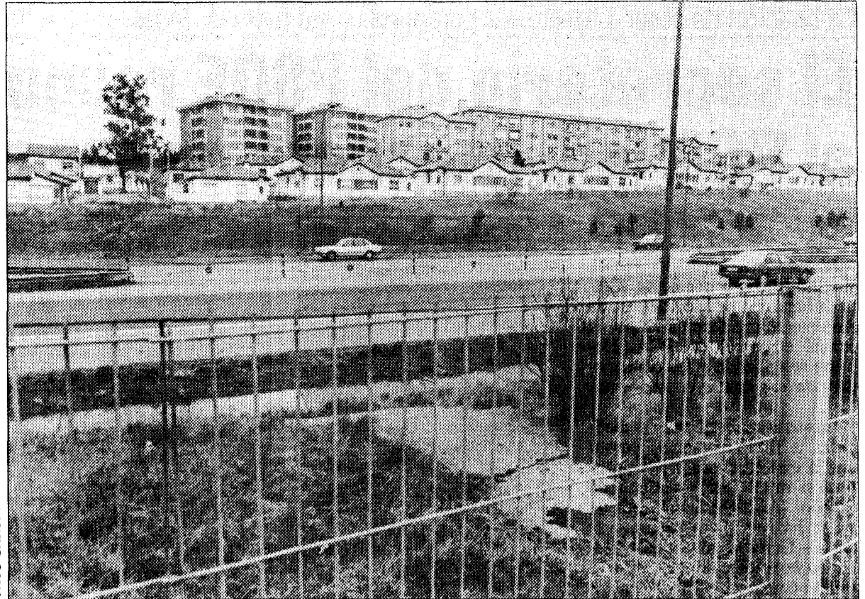
La construcción de la autopista partió al barrio en dos zonas.
