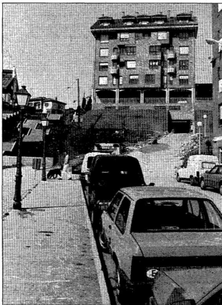
La constructora ha abierto un portón en el talud para dar acceso al garaje de los sótanos.
