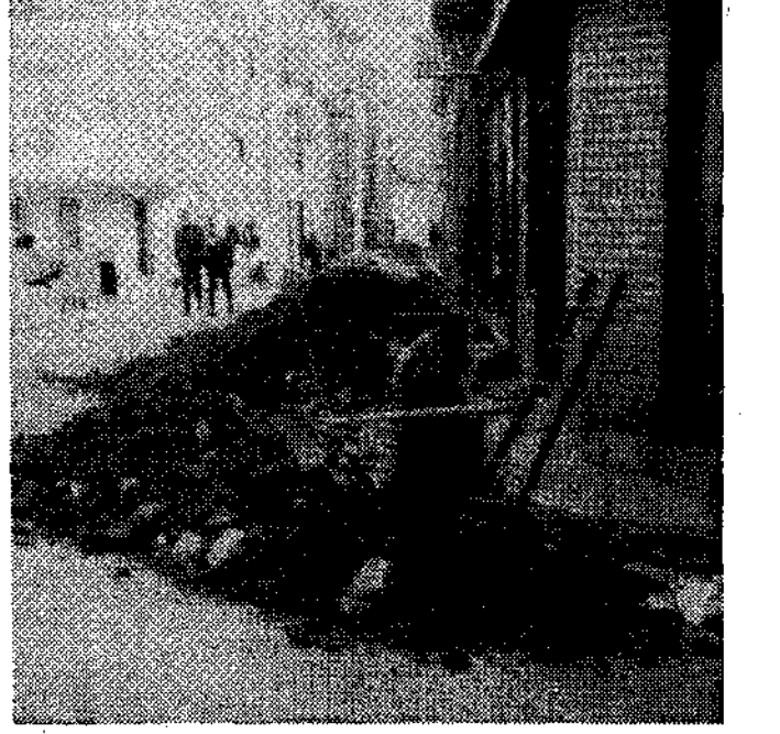
Obras en las calles de la villa.
