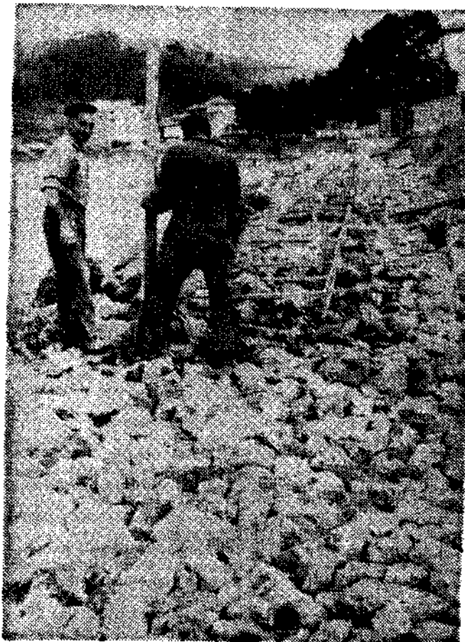
Preparación de la escollera
