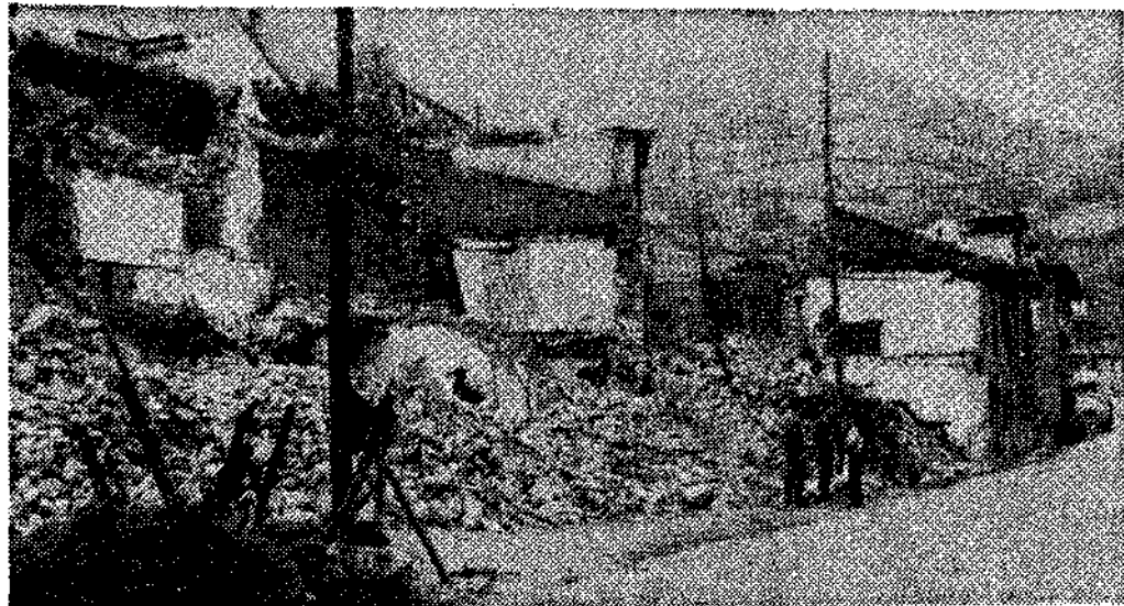
Casas de Vega del Ciego, derribadas
