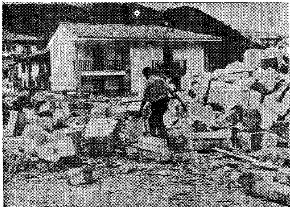
Grandes montones de roja caliza de Sebares, para que concuerden con el templo las construcciones a realizar.
