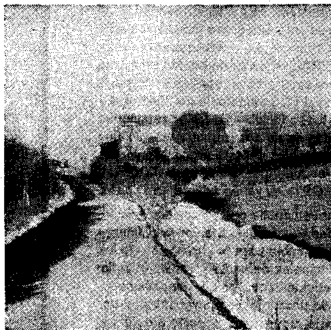
Tramo de camino ya terminado.
