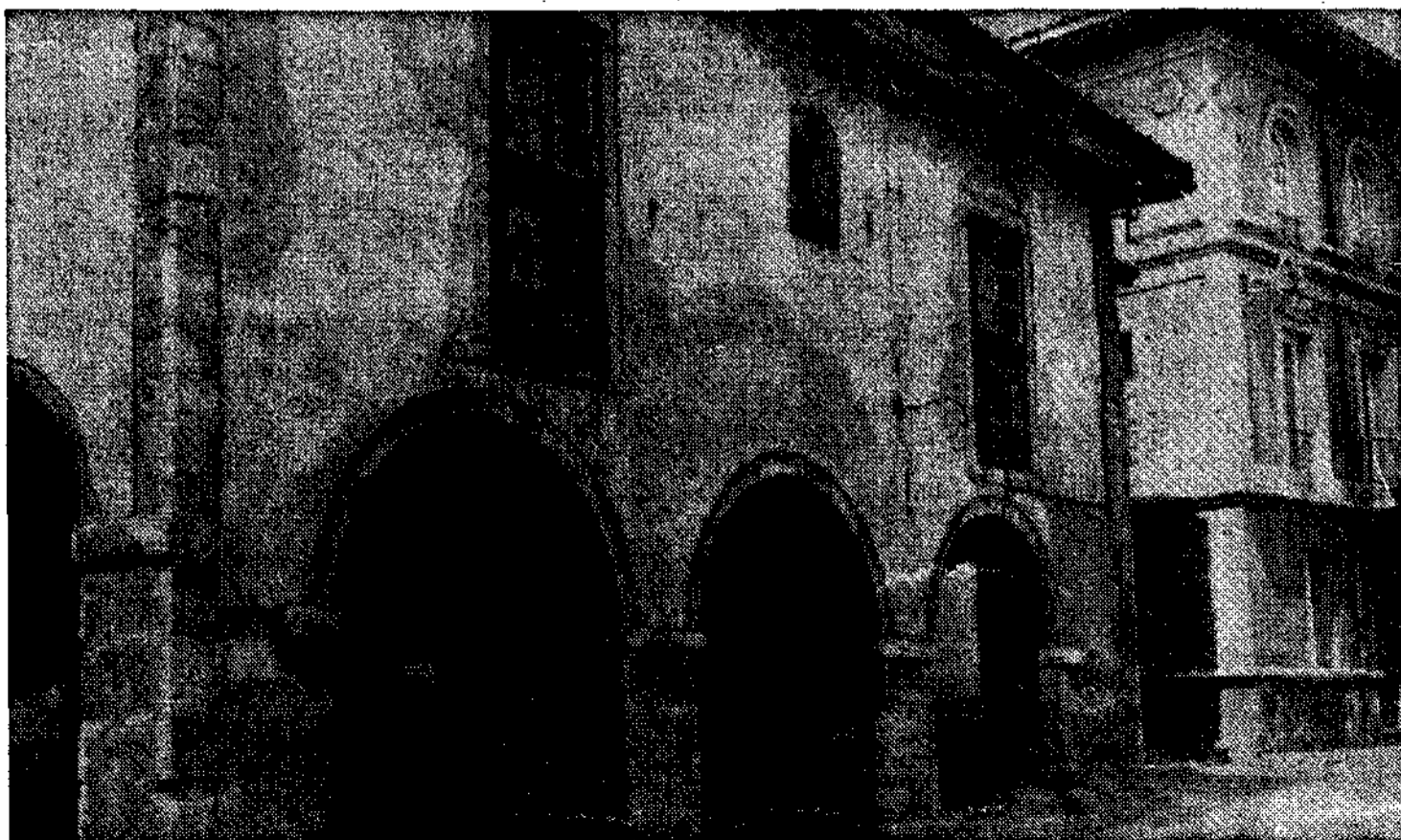
La Casona de los Arcos, rincón típico cargado de sabor marinero
