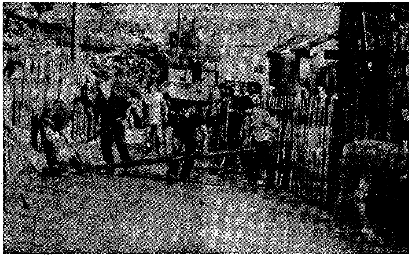
La comunidad de vecinos trabaja activamente en la construcción de su carretera.
