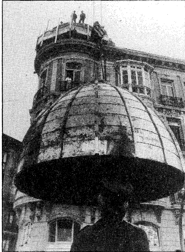
La estructura de cobre es izada desde la calle hasta la rotonda del edificio del marqués de Tremañes
