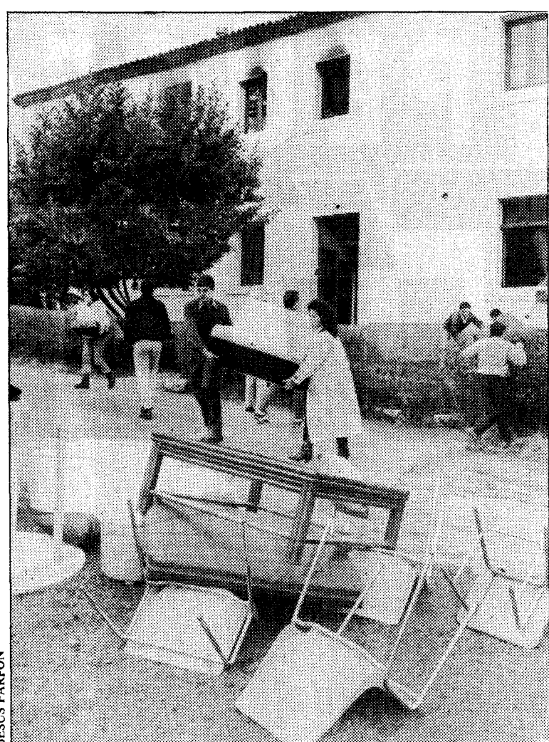
Parte del mobiliario de centro pudo salvarse antes de que se derrumbara la planta superior.
