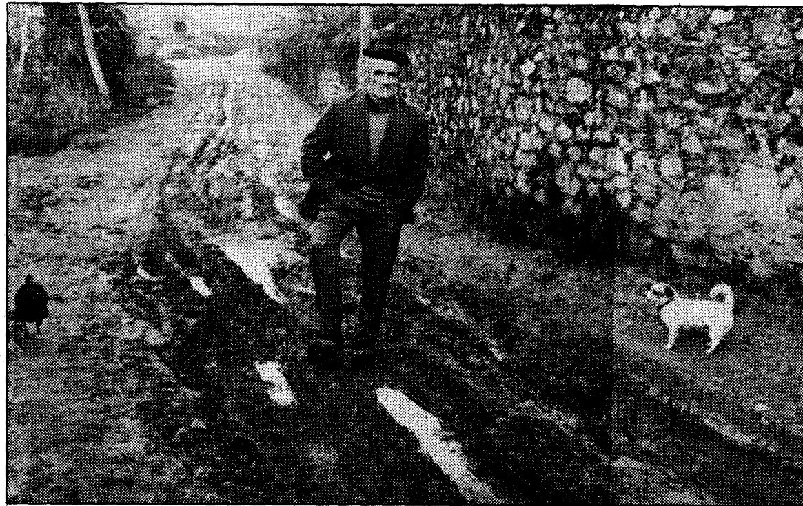
Bajo el enfangado camino transcurre el colector. Este tramo fue el que estuvo abierto durante 20 días y el que desató la polémica. A la derecha, Miguel Angel Tirador muestra el anteproyecto por el que se realizó el colector
