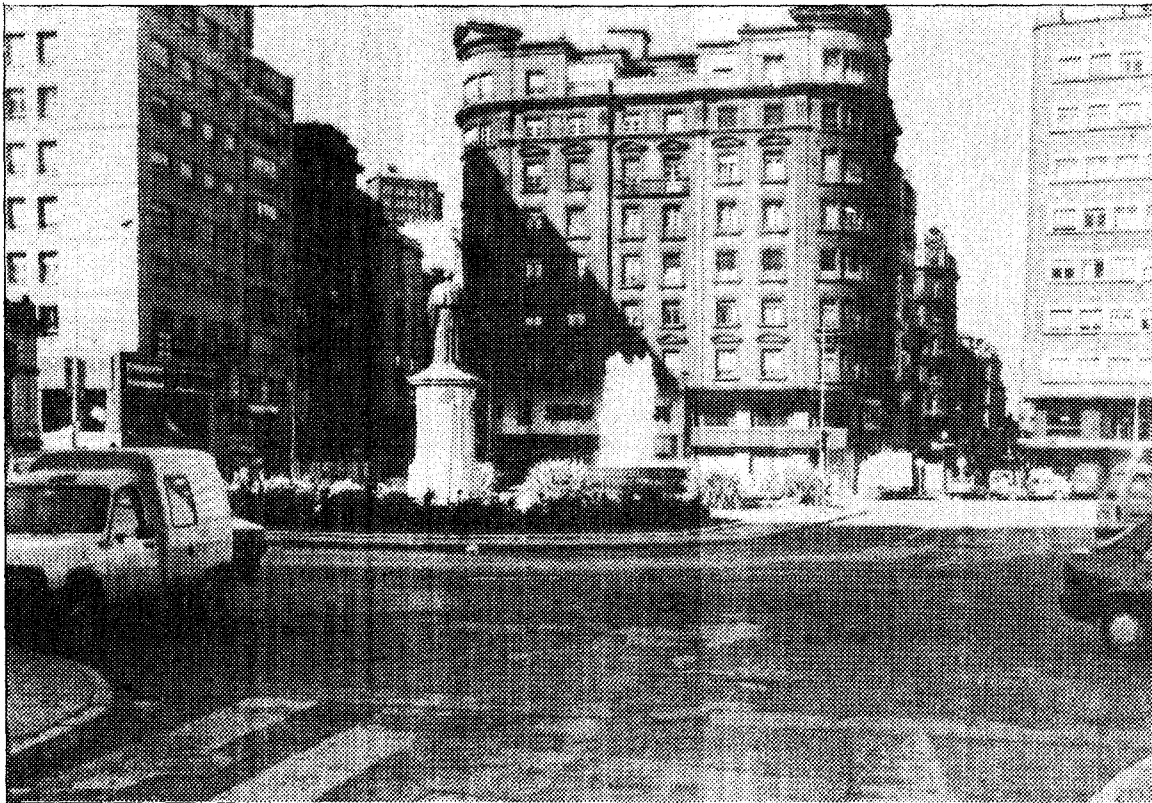
La construcción del «parking» hará cambiar la fisonomía de la plaza, que estará peatonalmente unida a la calle Corrida y calle Libertad, con el consiguiente cambio de tráfico.
