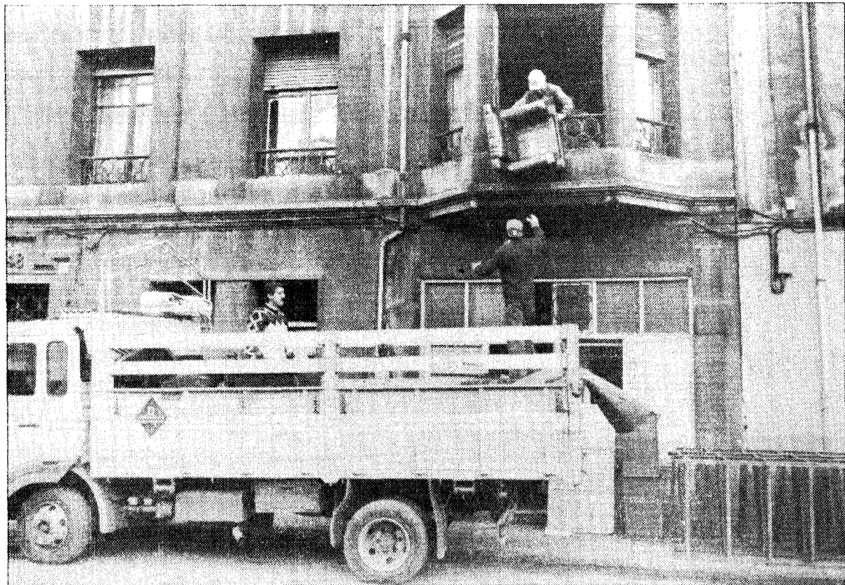
Las viviendas de la Carretera de la Costa, cuando fueron desalojadas.
