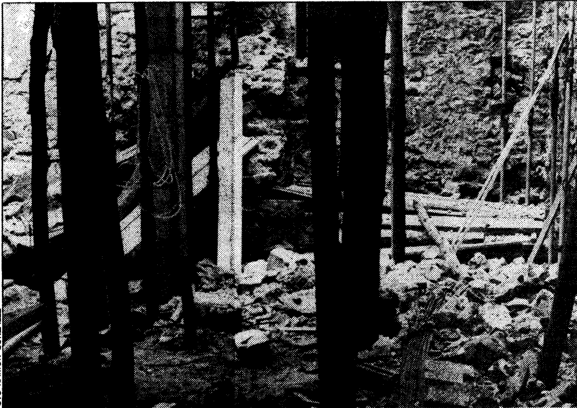
FOTO RAMON GONZALEZ Interior del restaurante en obras donde apareció la muralla romana
