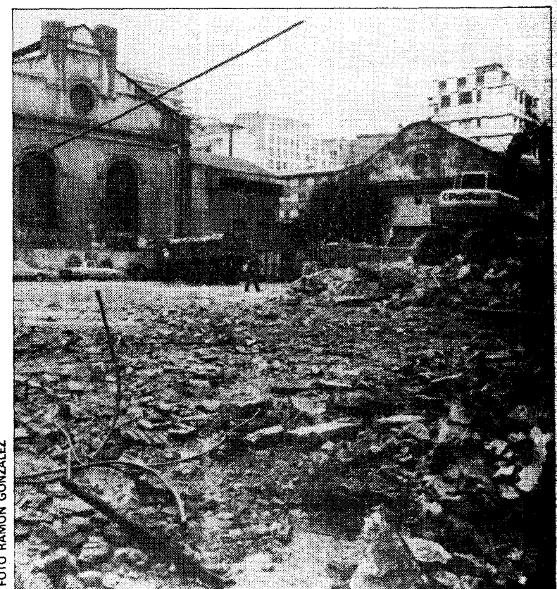
Derruida la Fábrica del Gas. Uno de los últimos reductos industriales del centro de la ciudad ha comenzado a ser demolido. Las instalaciones que la Hidroeléctrica del Cantábrico tiene en el barrio de La Arena, muy próximas a la playa de San Lorenzo, comenzaron estos días a caer por efectos de las palas para convertirse en un futuro en varias viviendas y una amplia zona ajardinada. La Fábrica del Gas, conocida instalación de los gijoneses, que durante muchos años cumplió con el suministro a las viviendas e industrias de la ciudad, hasta que la empresa instaló en Pumarín la planta de gas propanado, ha comenzado a caer, para dejar paso en un futuro a una nueva fisonomía urbanística.
