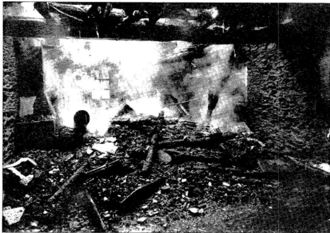
El incendio destruyó completamente tres de los apartamentos de La Rectoral y obligará al cierre del resto, dañado también por el fuego.
