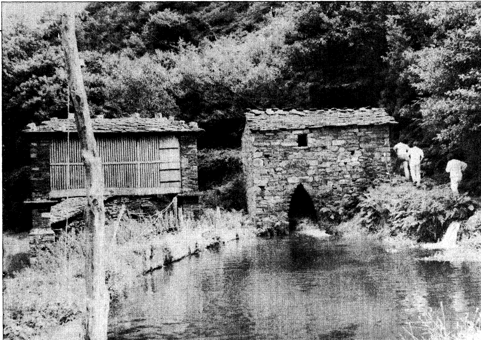
Vista frontal del banzao o depósito para almacenar el agua. Al fondo, el cabazo gallego y una de las paredes del molino
