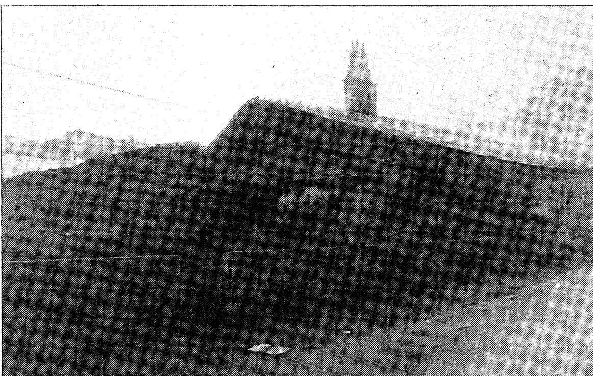
Vista exterior de la iglesia de Villanueva de Oscos, cuyas obras de restauración se interrumpieron hace cinco años, quedando en un lamentable estado.
