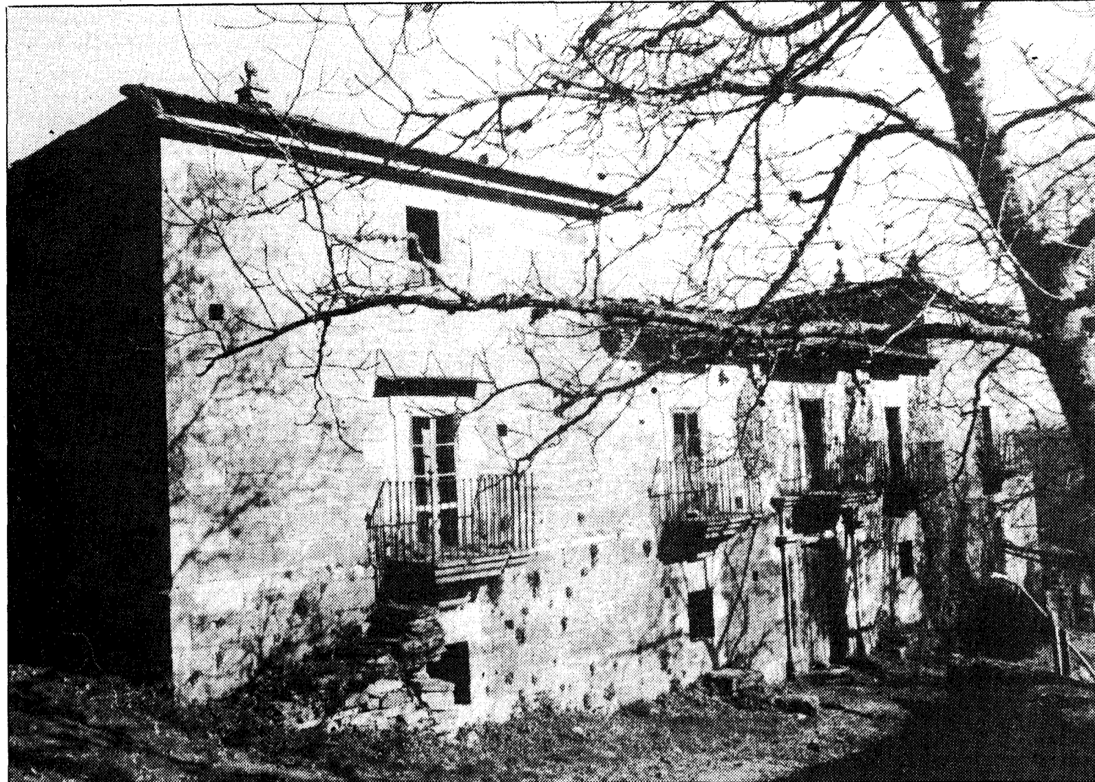
El palacio de Mon es una impresionante edificación pero que está muy deteriorada. El ex ministro Fernández de la Mora dijo que sólo restaurar el tejado le costaba «más de lo que gané en mi vida»
