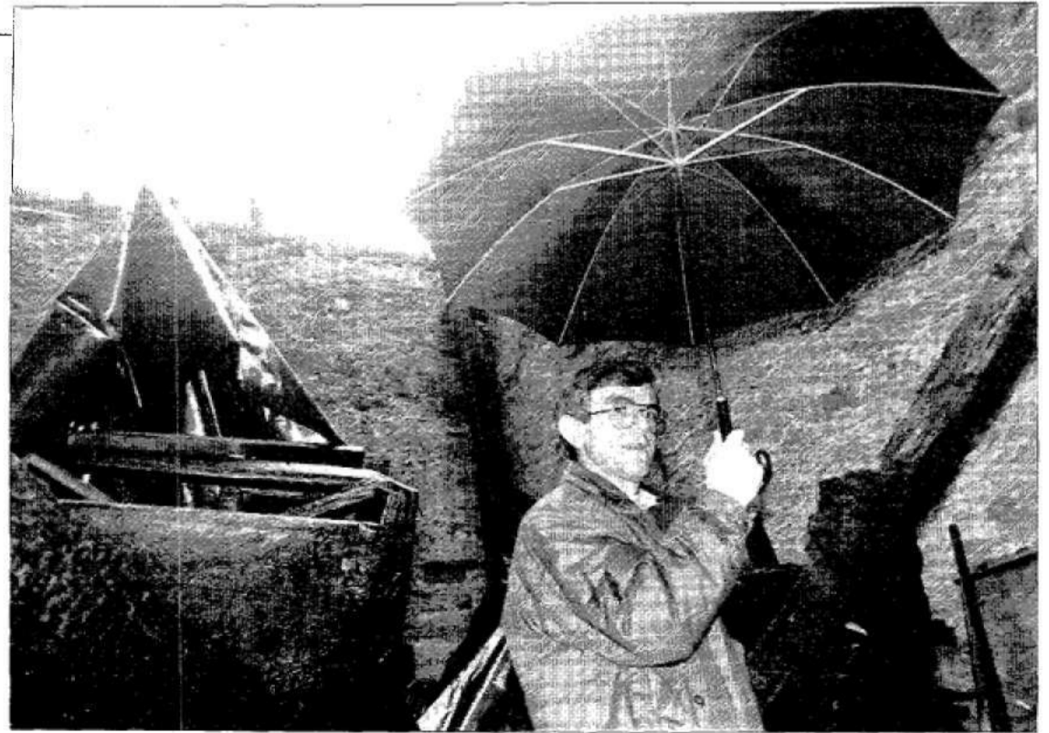
El párroco de Grandas de Salime, en el interior de la destrozada sacristía de la colegiata.
