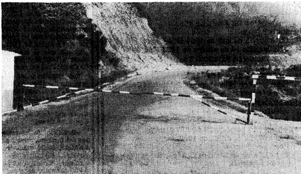
A las cinco de la tarde se baja la barrera que cierra la carretera de Degaña a tierras de León.
