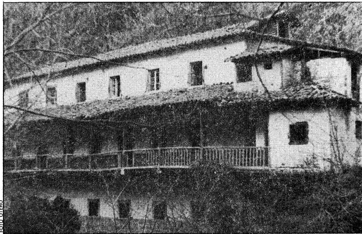
Edificio del balneario de El Puelo, que está en completo abandono
