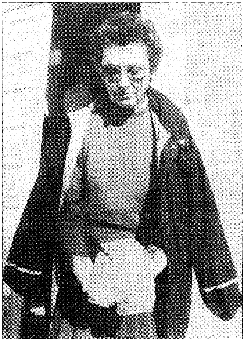
La directora del centro muestra en sus manos una piedra que se desprendió del edificio y pudo herir a alguien.
