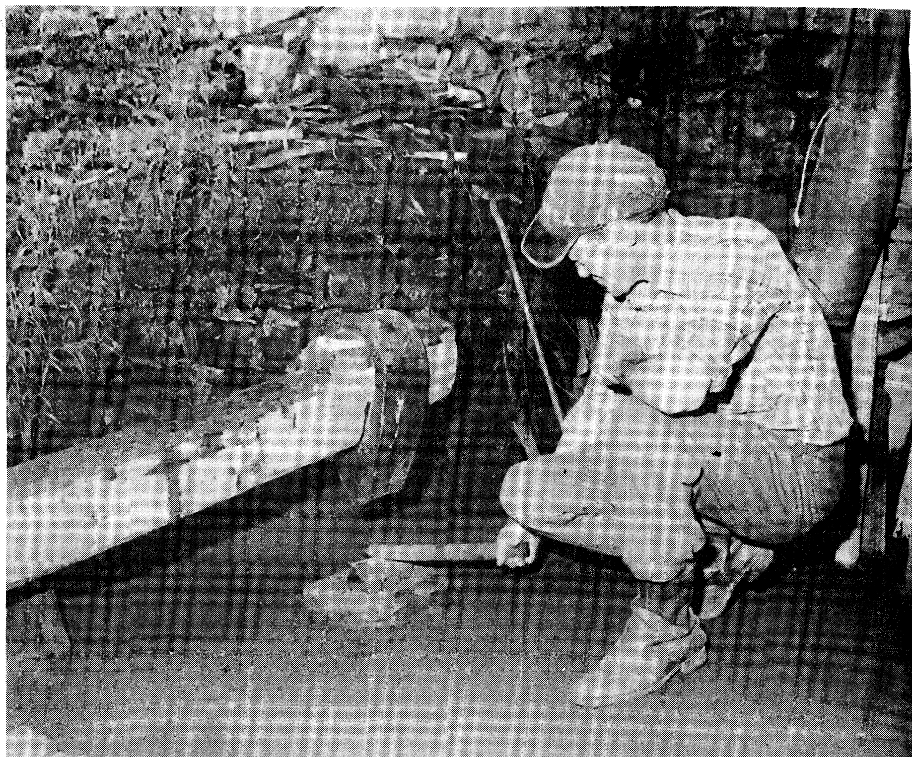
El peso del martillo cae sobre el hierro para aplanarlo.
