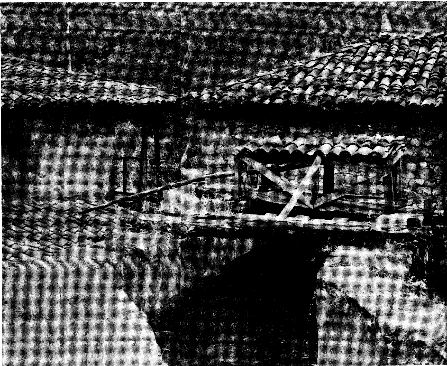
El agua llega al «camarau», que tapona la «mara». Desde el interior se mueve la vara que pone en movimiento el agua para accio
