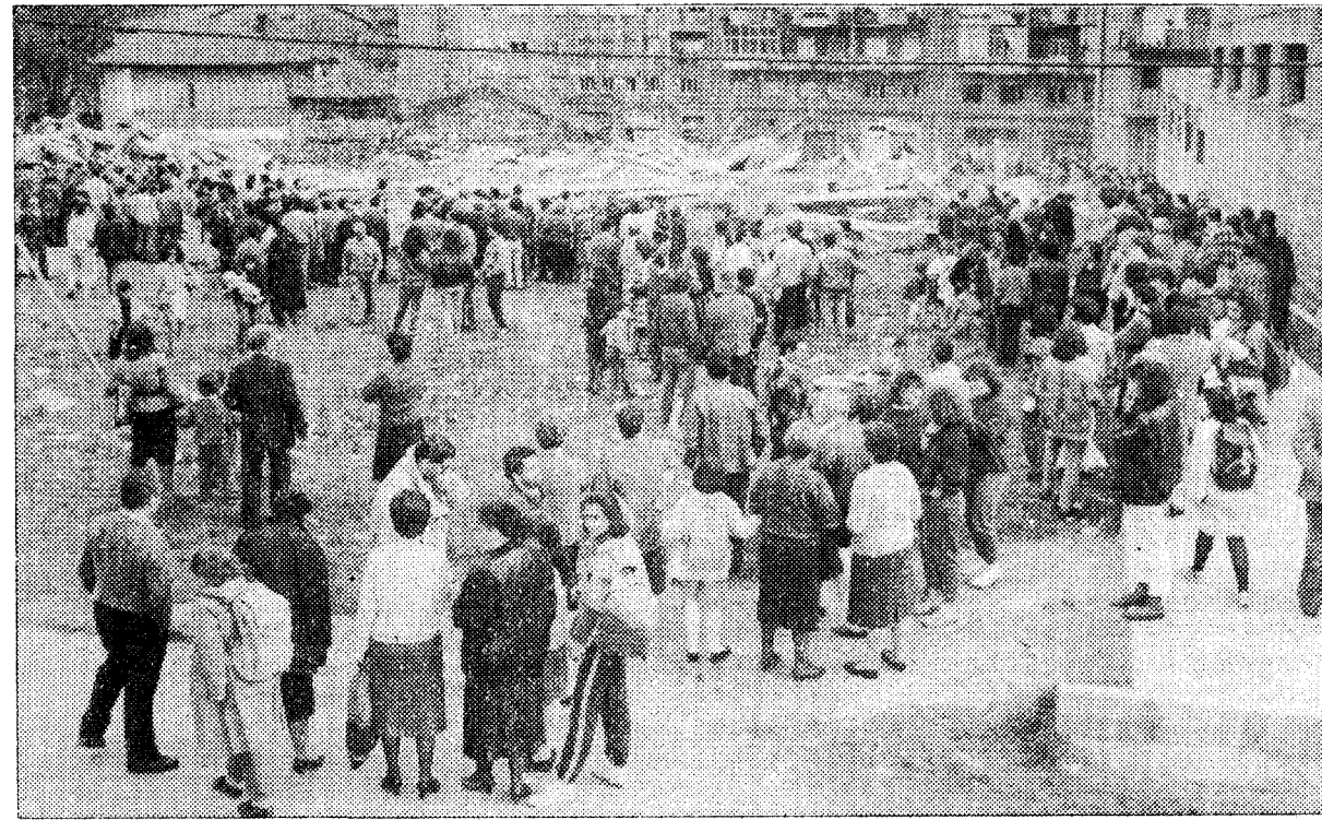
Dos imágenes de la voladura. Arriba, el edificio en pleno derrumbe. Abajo, los vecinos se acercan a los cascotes. La caída de la vieja estructura de hormigón fue acogida con voladores.
