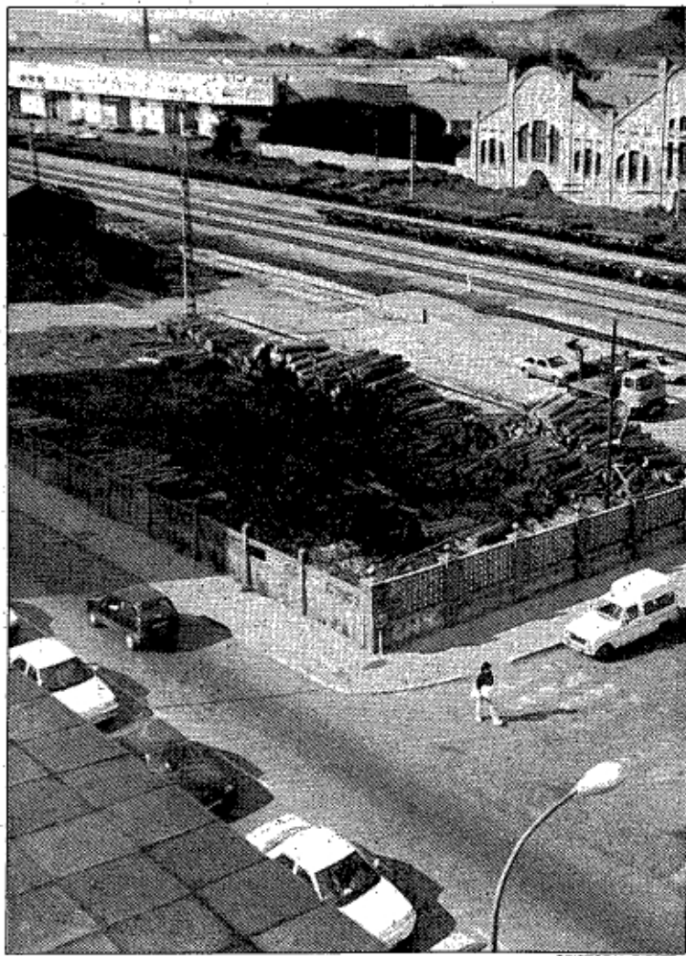
Una imagen de los almacenes donde se construirá la estación de autobuses.
