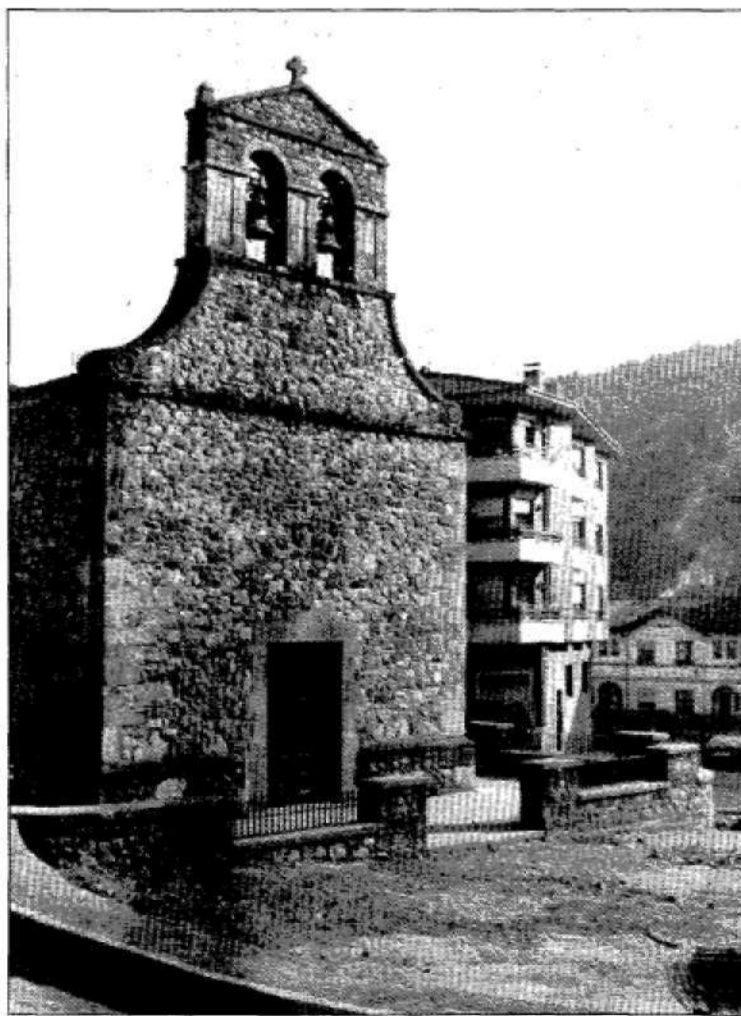
La plaza de San Julián de Bimenes se encuentra en obras.
