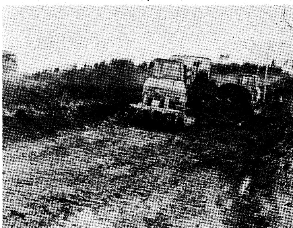
Abriendo la carretera que va a dar comunicación al pueblo de Quejo.
