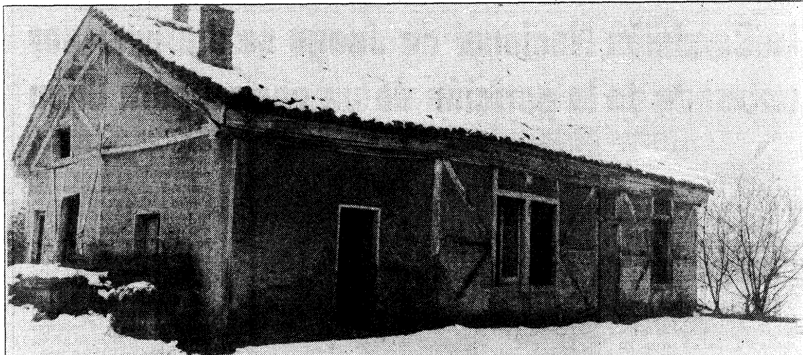
El viejo edificio destinado a bar y economato para los mineros, aún conserva ciertas huellas de estilo arquitectónico inglés. Fundado en 1893, pertenece a una compañía asturiana que quiere volver a habitarlo para explotar unas minas de cobre
