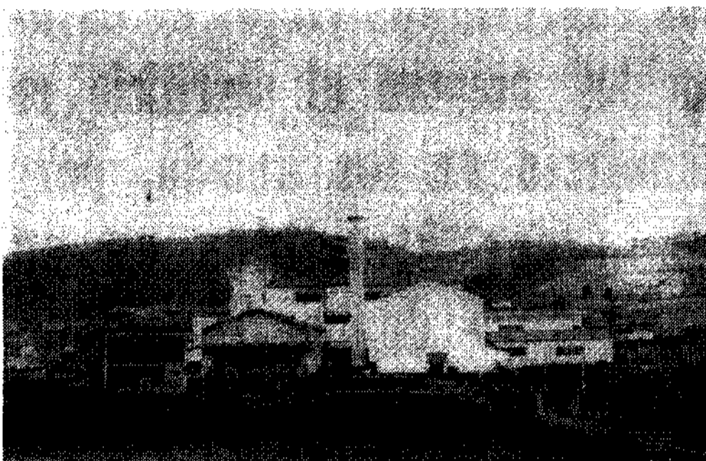
La fábrica de extractos curtientes, en Grado, posiblemente la única de su tipo que aún funciona en España. Su porvenir es incierto: si no se construye la proyectada fábrica de papel, es muy probable que cierre sus puertas.
