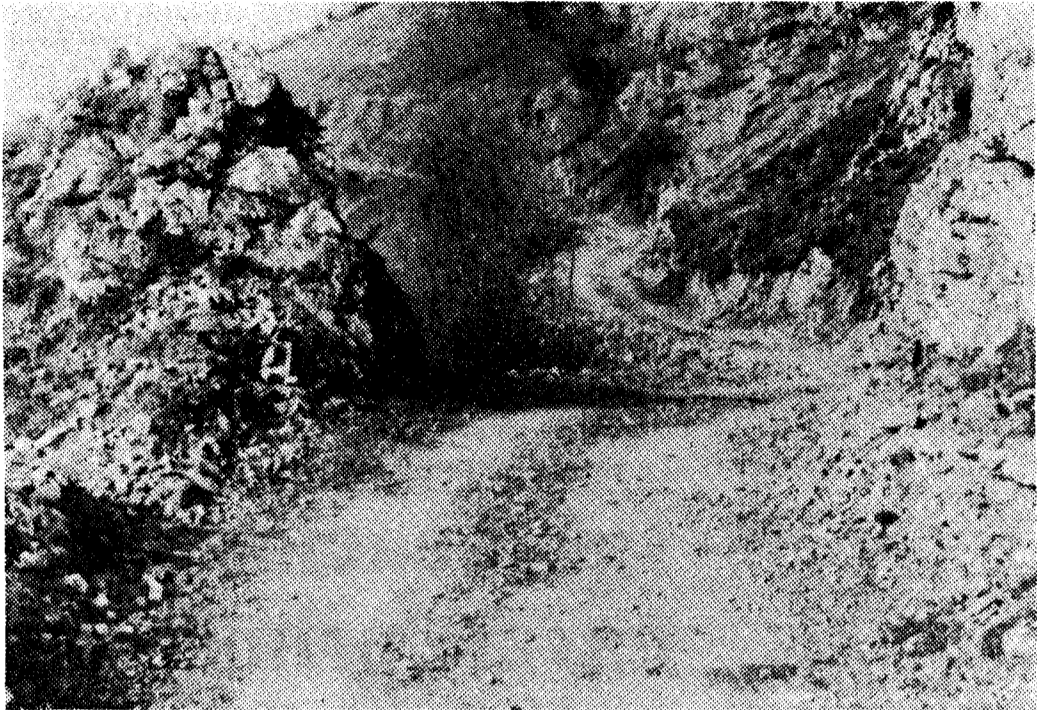
La carretera que los vecinos llaman de la dinamita por la gran cantidad de explosivos utilizados para abrir paso por la roca
