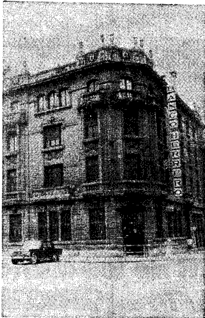
Este es el vetusto edificio para derribar en un futuro inmediato. (Foto Ortega.)
