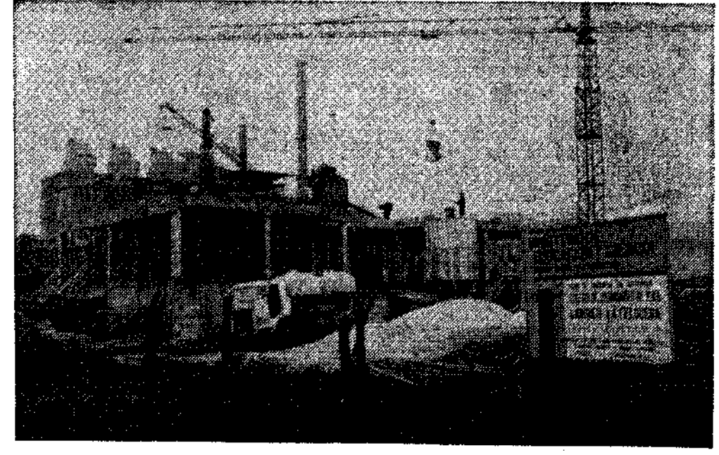
Se han iniciado a buen ritmo las obras de construcción del colegio de básica de La Felguera.—(Foto Ortega.)
