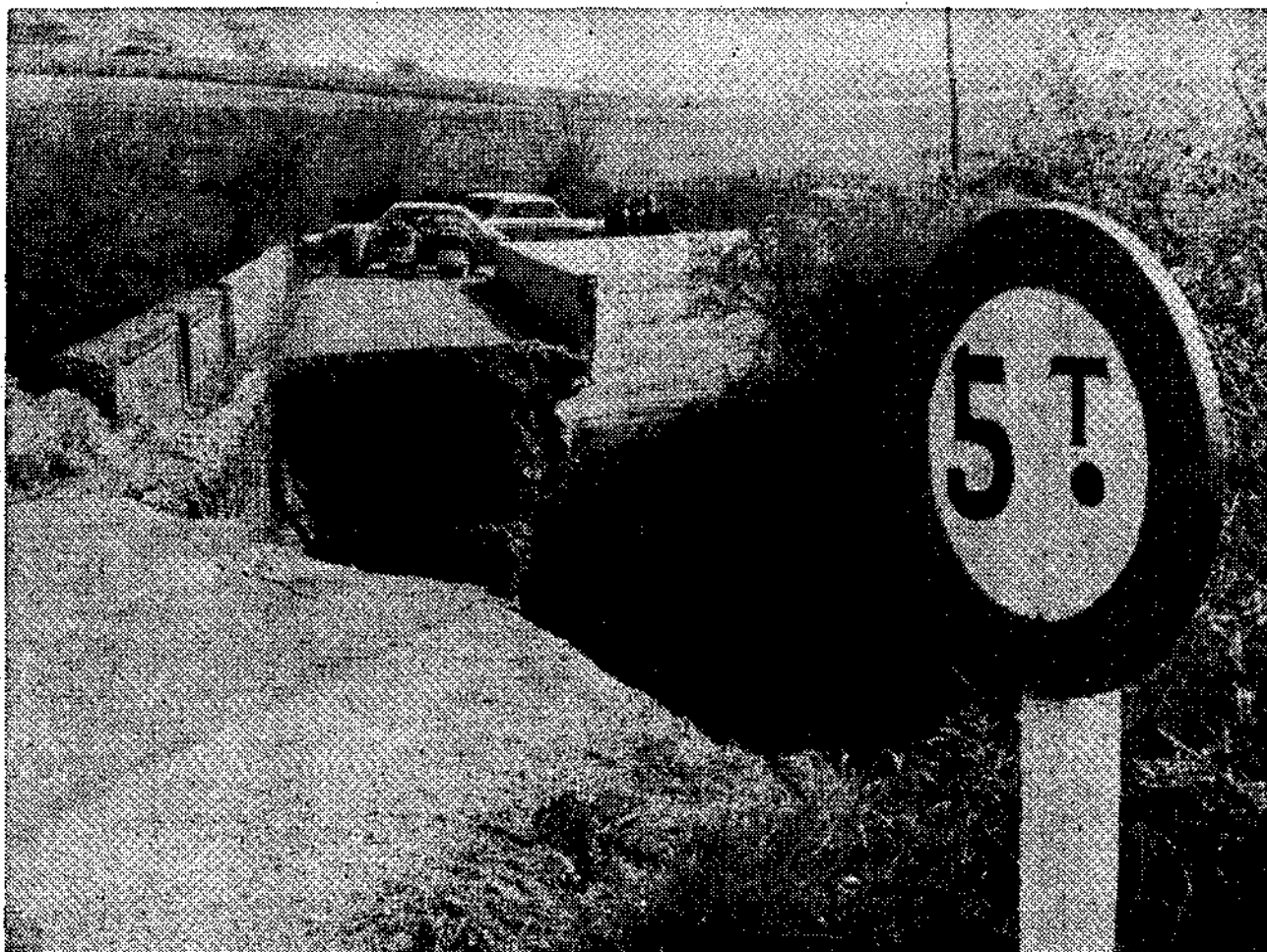
Una clara advertencia: cinco toneladas, carga máxima. ¿Fue el exceso de mercancía lo que motivó el derrumbe?
