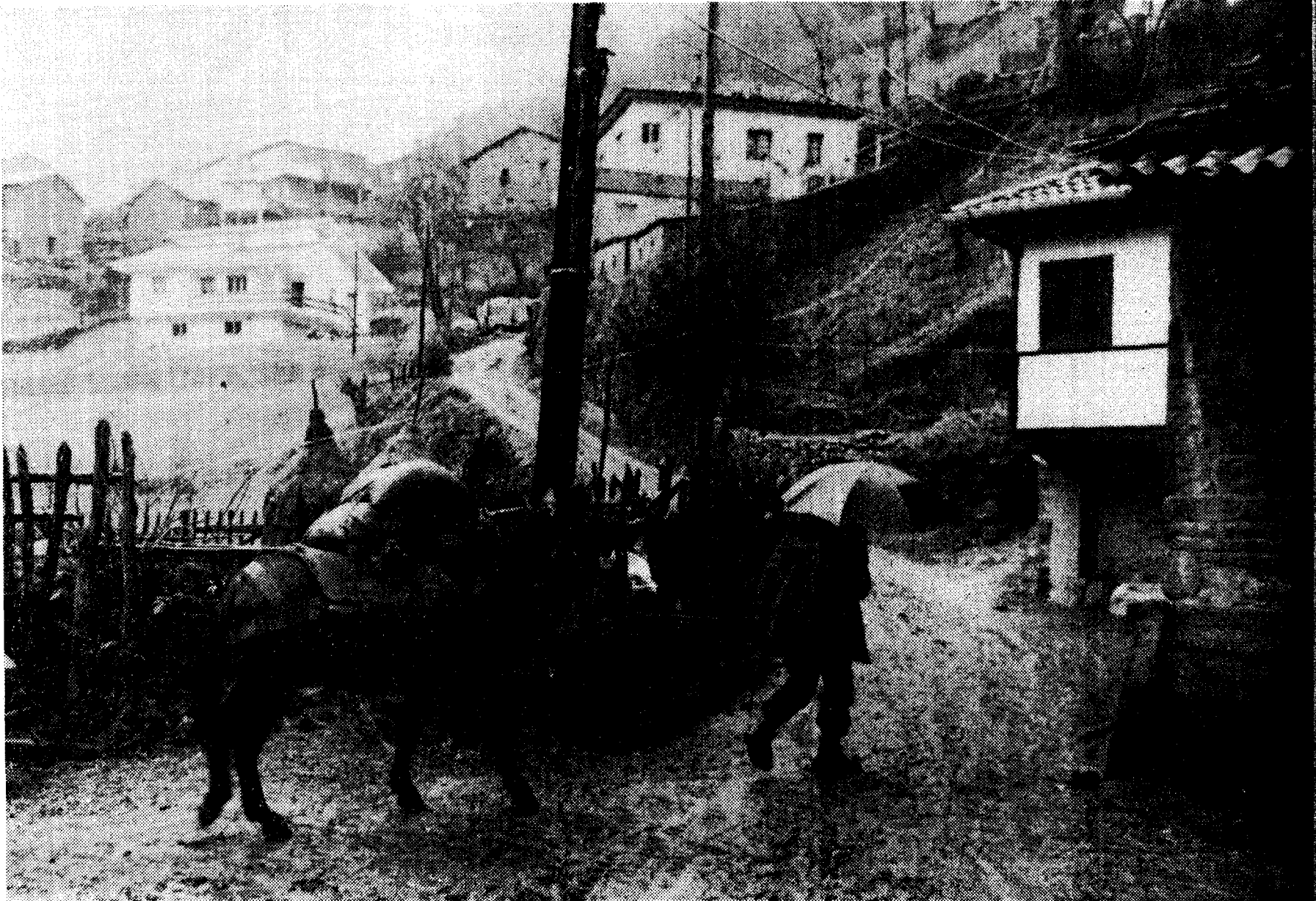
Muchas de las obras de Villandio han sido realizadas gracias al trabajo conjunto de todos los vecinos, como la red de saneamiento y el asfaltado de la carretera
