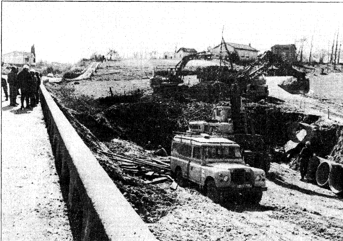
A la entrada de Nava, en dirección a Santander, a la izquierda de la calzada, ya se aprecia el movimiento de tierras.
