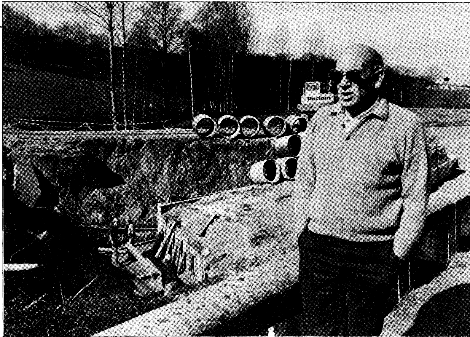
El alcalde de Nava, Francisco Fernández, en el lugar donde se iniciaron las obras de la variante.
