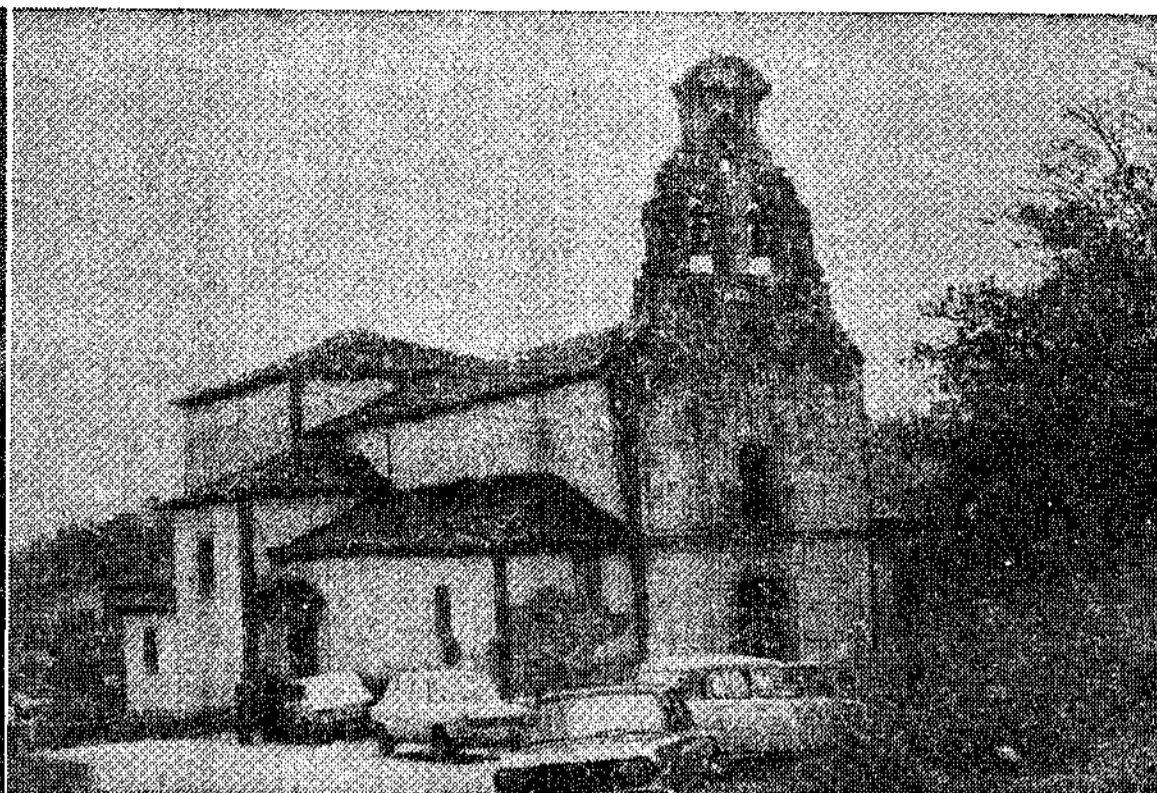
Exterior de la iglesia de Santianes
