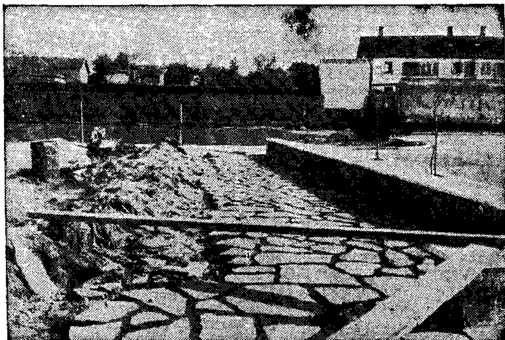
Próximo al pasco de la playa se construye un pequeño parque. En el centro llevará una fuente con estanque.
